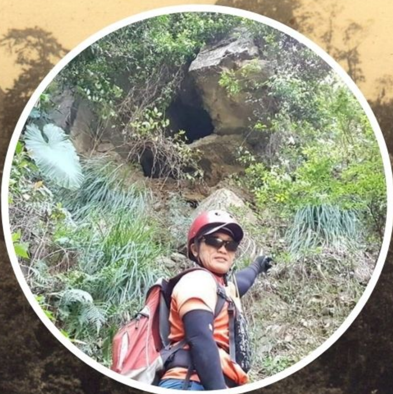
裡冷隧道(東口)
